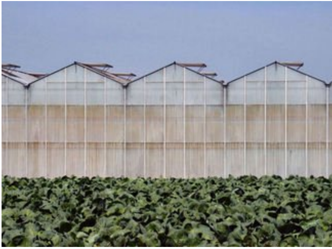
Connecté avec gouttières
